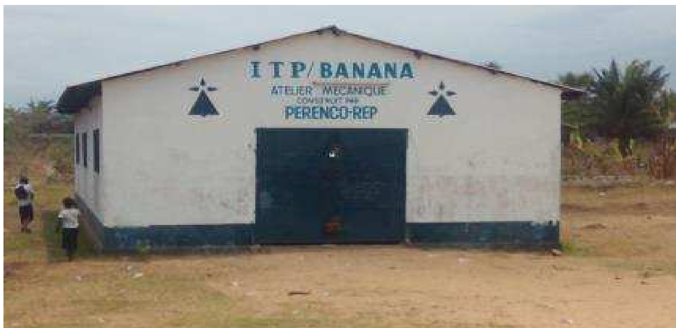
Photo 2 : Le bâtiment de l'atelier mécanique destiné aux écoles techniques de Muanda construit par Perenco dans l'enceinte de l'ITP Banana pour un montant de 20.000 Usd (action sociale conventionnelle).
