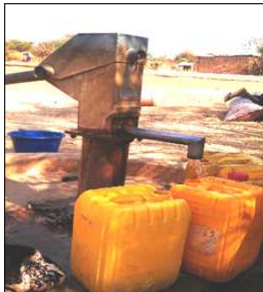
Photo 15 : Puit de SONGO encore opérationnel
