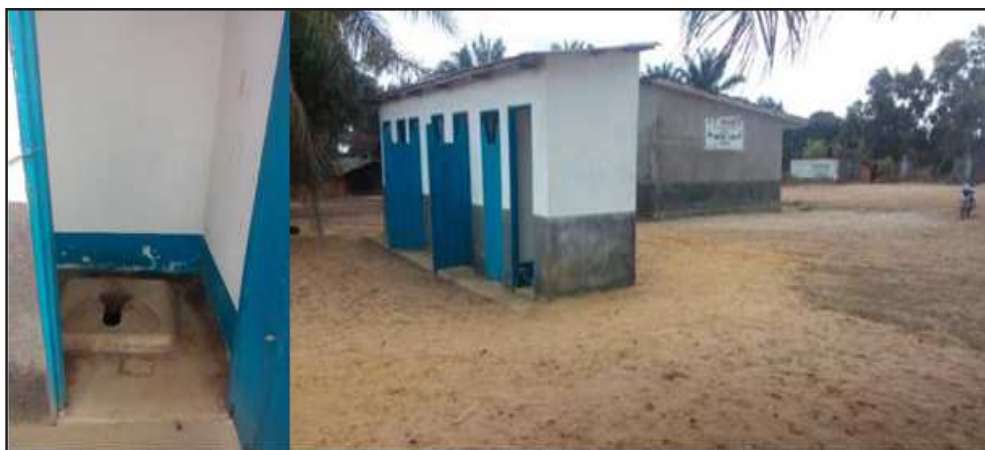
Photos 3 et 4 : Latrines scolaires construites en 2013 par Perenco à l'école primaire Ndundji, village situé à plus de 15Kms de Muanda sur la route de Yema pour un montant dont la hauteur n'est pas connue par le public.
