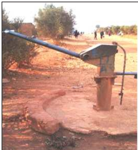
Photo 15 : Puit d'eau du Quartier MINE
