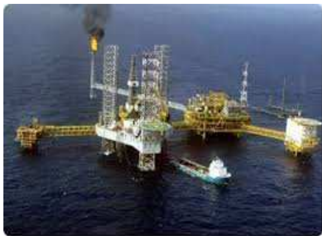
Figure 1: Une plate-forme d'exploitation offshore
